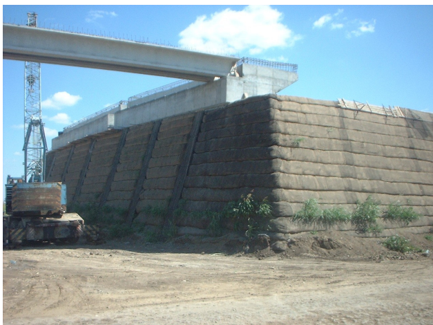
Geogrile Fortrac - rampe pasaj Drajna pe A2
